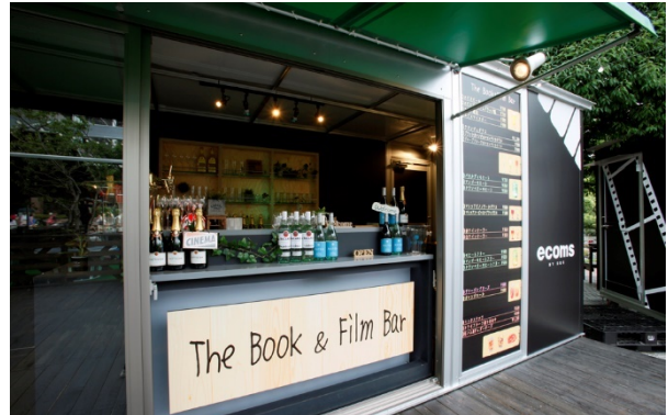
オーニングの構造材も SUS のアルミ製
