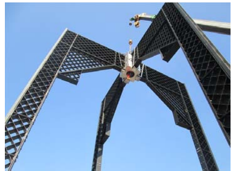
▲仮組みの様子(9月22～23日実施)
