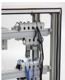
新形状の自立型DINレールにより3D構造化。 中板が省かれ、背面に配線スペースができました。
