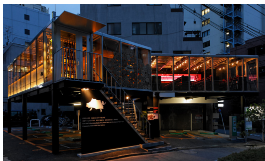
左上)MOOR LUSSO 外観。夜は一際“宙に浮く”空間に。 右上)同店内部。 下)2号店として昨年11月赤坂にオープンした「黒豚劇場」 携帯電話で写真を撮る人もいるというインパクトある外観
