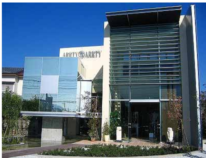
▲ ARRTY@ARRTY 外観 (左側が tsubomi) デザインを担当した建築デザイナーの戸谷氏は、「アルミパネル構造で軽量の tsubomi だからこそ、支えとなる脚の部分をスリムにし、“離れ”が浮いている軽さを表現することができました」と語っています。
